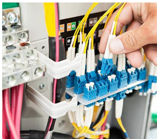
Panel para instalación de fibra óptica
