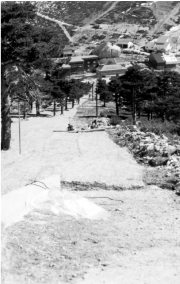
Instalación de Manta orgánica en la pista del Telégrafo.
