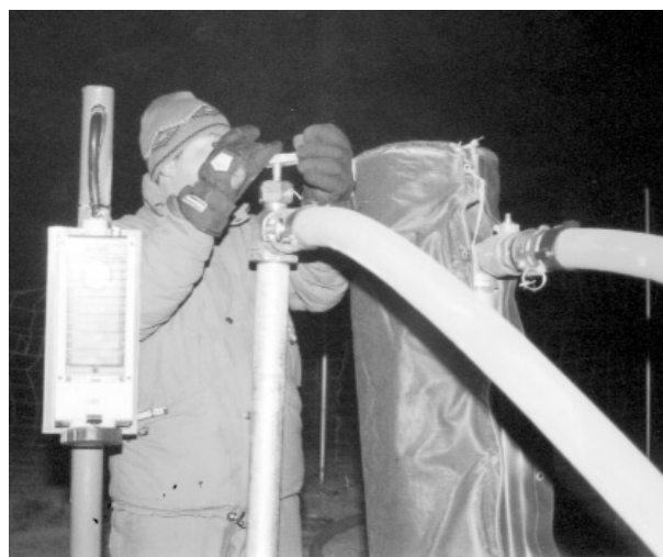
Accionamiento de los hidrantes.
