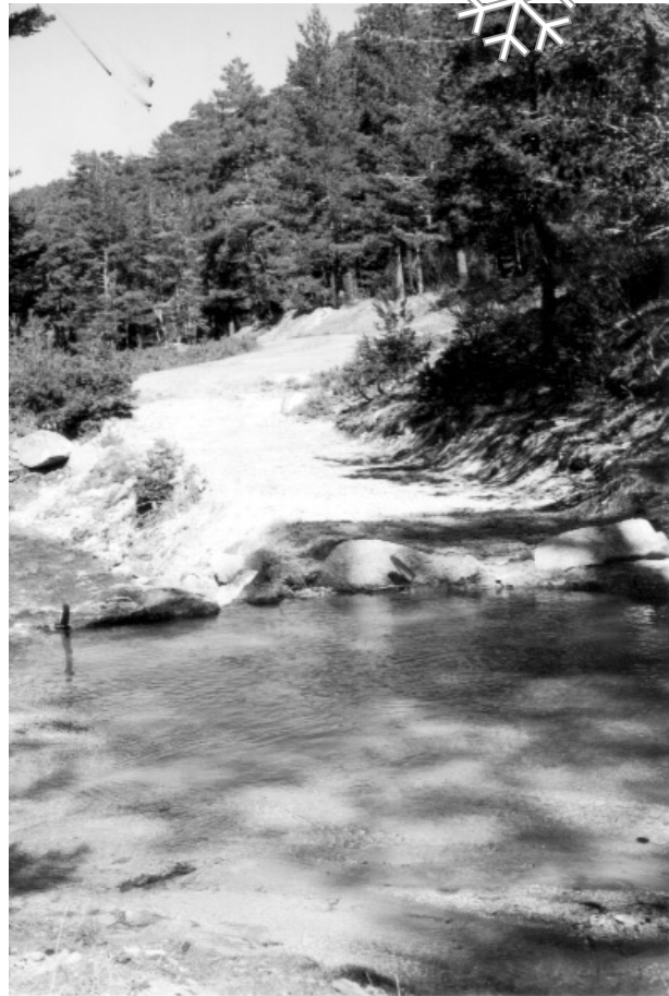
Restitución realizada en el cruce de la tubería con uno de los arroyos.
