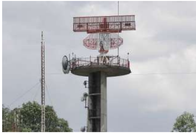
Figura 1. Torre de comunicaciones aeroportuaria.
