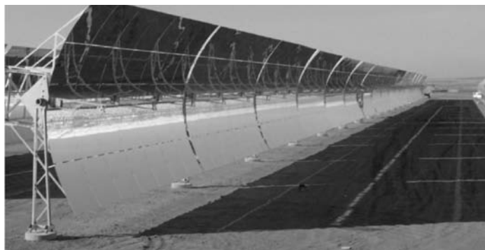
Figura 7. Concentrador cilindro-parabólico (Abengoa). En la parte posterior se encuentran los mecanismos de seguimiento del sol.
