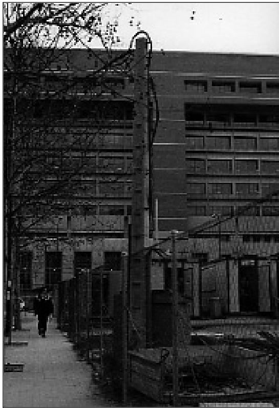
Foto 1. Instalación provisional para una obra.
